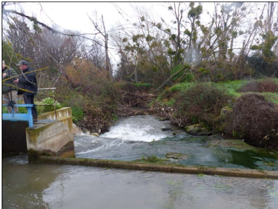
Ilustración 33. Sensores de nivel en el cauce del Queiles en Calchetes , en el término municipal de Tarazona.
