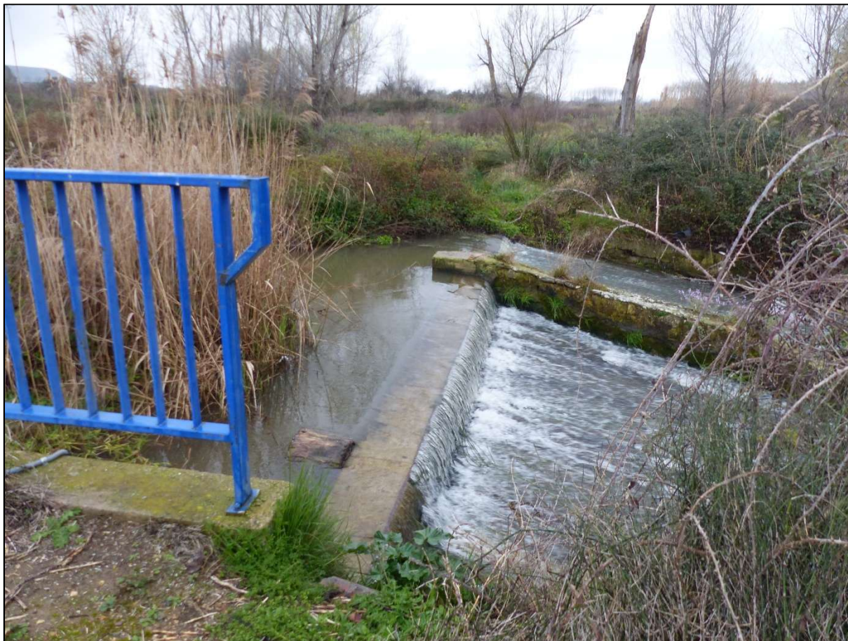
Ilustración 9. Imagen de la estación de aforo – usos de regadío - del río Queiles en “ Las Comunidades ”, en el término municipal de Malón.
