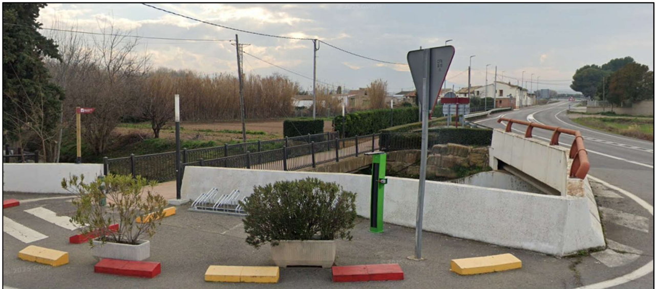
Ilustración 16. Imagen, del puente de la carretera N-121-C a su paso por la localidad de Tulebras. Imagen obtenida de Google.
